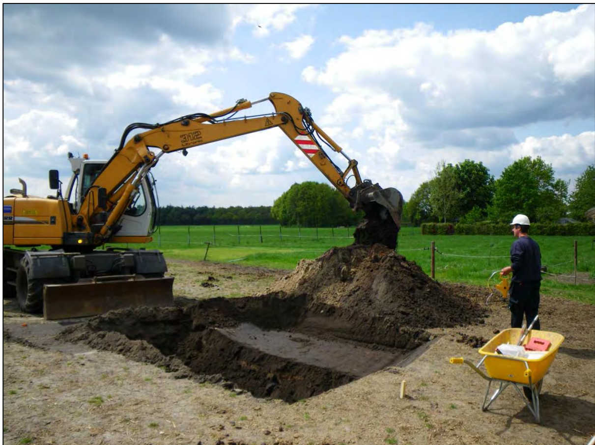
Figuur 3: Foto van de werkzaamheden.
