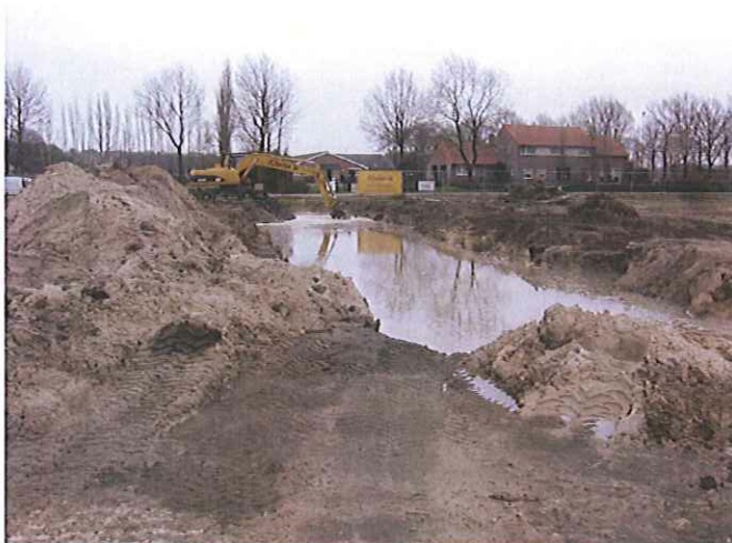
Foto ontgravingsput (kijkrichting van west naar oost)
