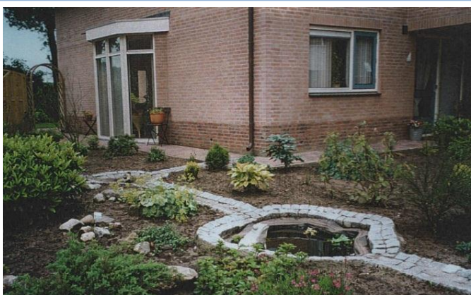
Afbeelding 11 afkoppeling dak en richting vijver.
