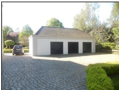
Figuur 3. Te slopen bijgebouw
