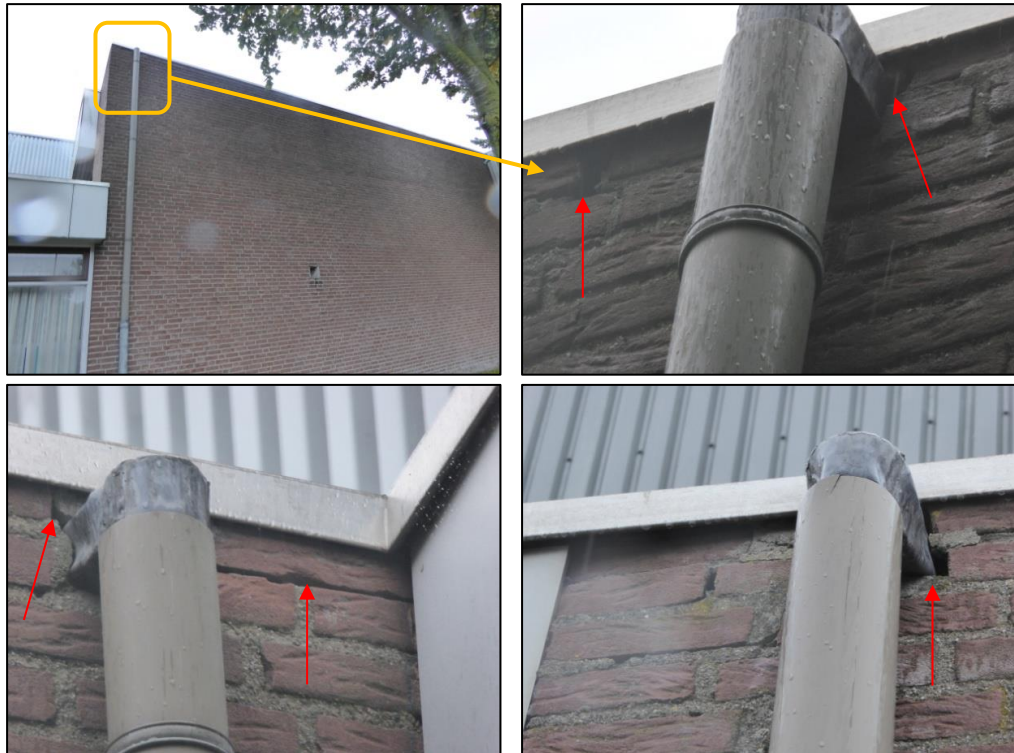
Ruimte tussen regenpijpen en de muur van de sporthal.
