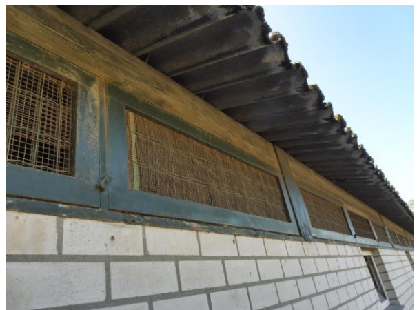
De afgesloten luchttoevoer in de zijgevel
