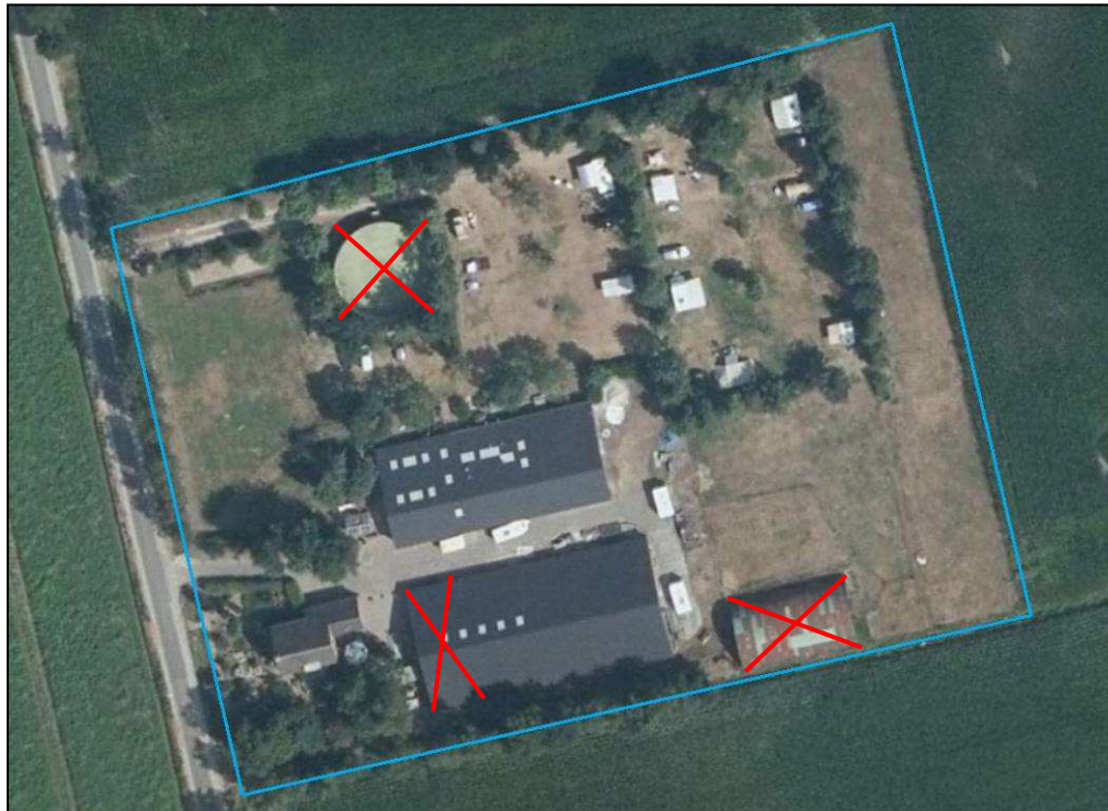
Figuur 1: Overzicht te slopen bebouwing
