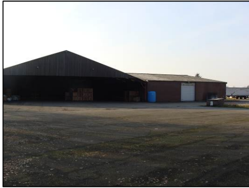
Foto 5. Te slopen bedrijfspand
