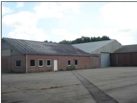
Aanzicht twee bedrijfsloodsen en verhard voorerf
