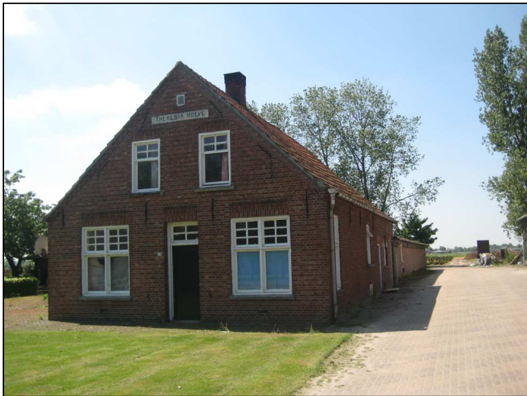
Figuur 19: Cultuurhistorisch waardevolle bebouwing ter plaatse van het plangebied
