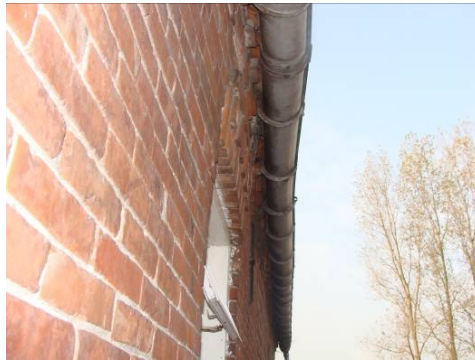
Foto links: Hoek voorgevel – linkerzijgevel: voorgevel is steens en kruisverband, zijgevel is uitgevoerd als spouwmuur en in halfsteensverband opgetrokken. Voegwerk dient grotendeels hersteld te worden.
