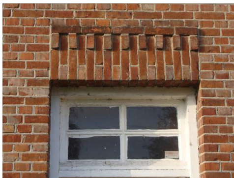
Sierlijke strek boven de voordeur / de oorspronkelijke schoorsteen.
