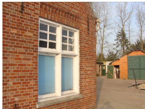
Kopgevel met naambord en schuiframen / onderkozijn met schuiframen en typerende bovenramen.
