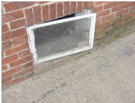
Foto links: kelderraam is aan vervanging toe, en dat is niet voor de eerste keer.
