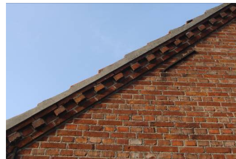
Zijgevel met bloktand (achter de mastgoot) en muurankers / voorgevel met bloktand en smeerrand.
