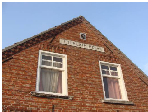
Kopgevel met naambord en schuiframen / onderkozijn met schuiframen en typerende bovenramen.
