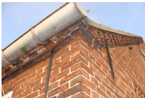
Zijgevel met bloktand (achter de mastgoot) en muurankers / voorgevel met bloktand en smeerrand.
