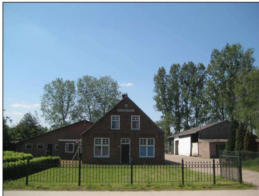
Afbeelding: te handhaven toegang tot de woning welke zal worden uitgebreid aan de voorzijde van de woning. Aan de achterzijde van de woning zijn tevens de te behouden populieren zichtbaar
