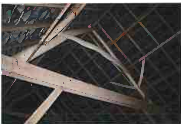
Het schaarspant met ingekeekte dwarsbalk
