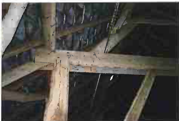
Detail: dubbele dekbalk
