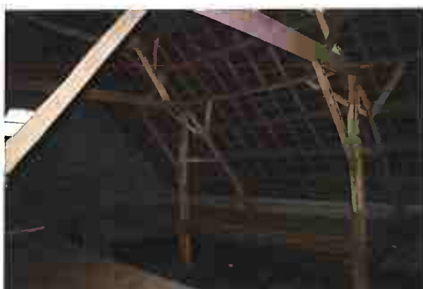
De staanders en de onderste spantbenen met windschoren
