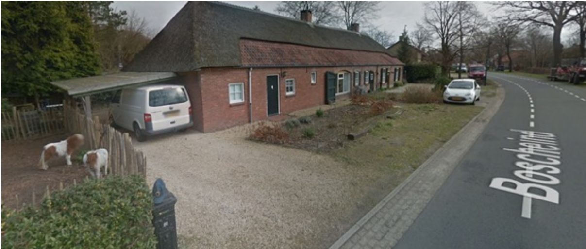
Illustratie van de bestaande langgevelboerderij aan de Boscheind, van links naar rechts: nr. 80, 78 en 76 (GoogleMaps streetview)
