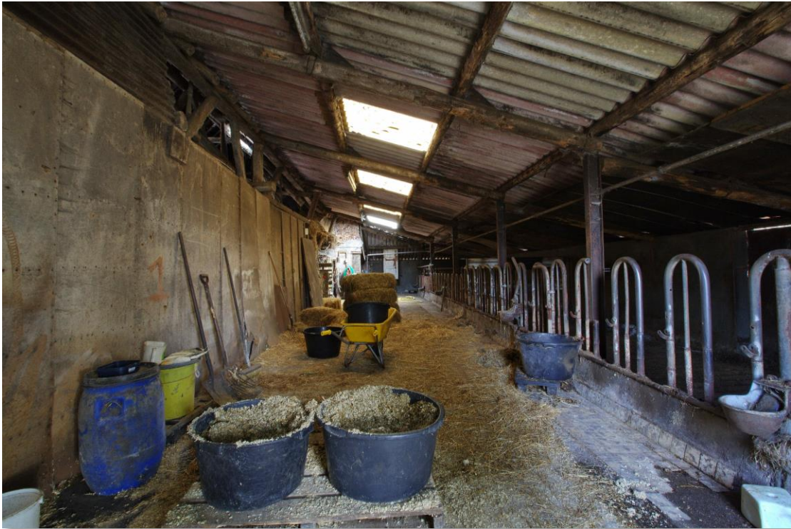
Figuur 7F: veestal met dak van eterniet golfplaten.
