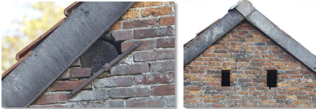
Figuur 11A en 11B: zijgevel van de binnenplaatsschuur met in- en uitvliegopeningen voor onder andere vleermuizen.
