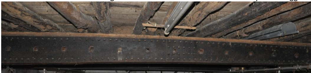
Afb. 26. Aanzicht molenroede met slieten en planken zoldervloer.
