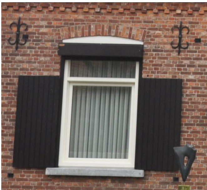
Afb. 14. Kunststof raam met rolluik en luiken bevestigd tegen de gevel.
