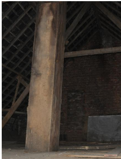
Afb. 24 ventilatiekoker op zolder.
