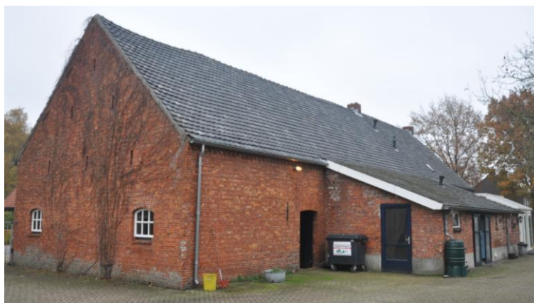
Afb. 21. Achtergevel en eindgevel.
