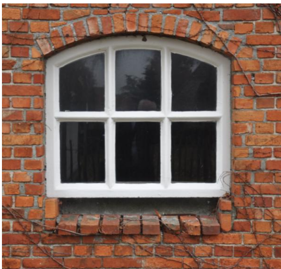
Afb. 23. Betonnen stalraam met ventilatietoever.
