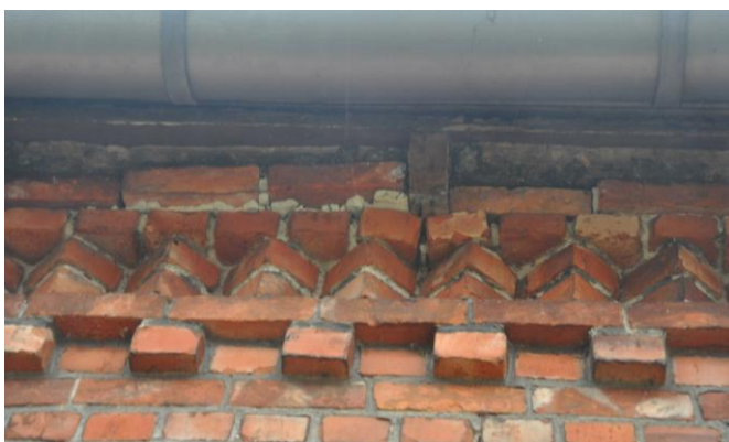
Afb. 12. Fries onder de goot ( bloktand, strekkenlaag, dubbele muizentand, koppenlaag en strekkelaag)
