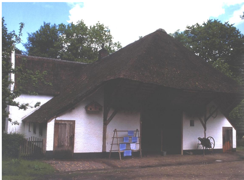
Afb. 10. Hallehuisboerderij met bedrijfszijde naar de weg gekeerd.
