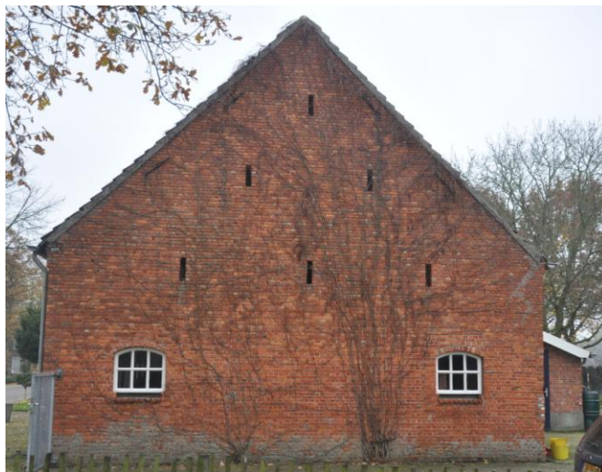
Afb. 18. Aanzicht eindgevel met ventilatieopeningen en twee toegevoegde stalramen.
