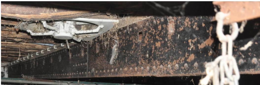
Afb. 25. Geklonken molenroede en ventilator onder de ventilatiekoker.
