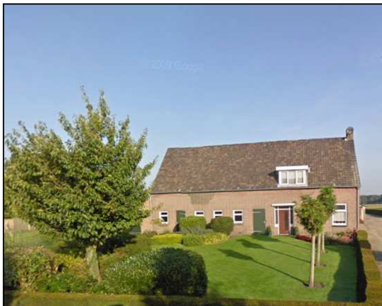
Figuur 8: Bestaande bedrijfswoning op de locatie Weebosch 8
