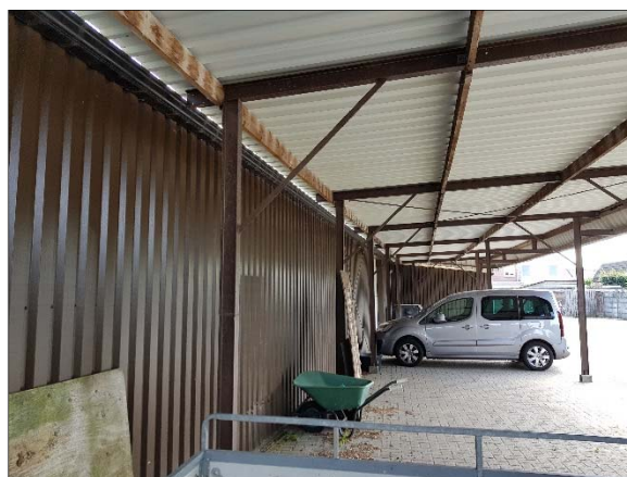
Figuur 7. Overkapping aan de westkant van de bedrijfshal
