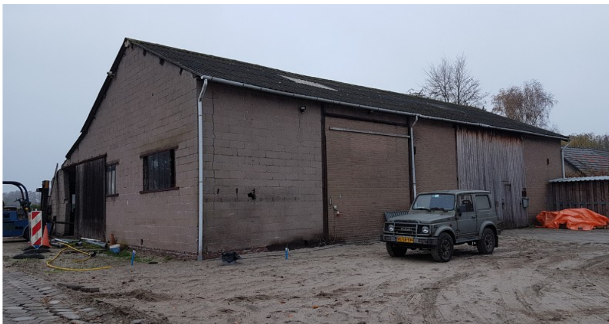
Oostelijke en noordelijke gevel van de te slopen loods. Foto: B. Verhoeven | Ecoresult B.V.
