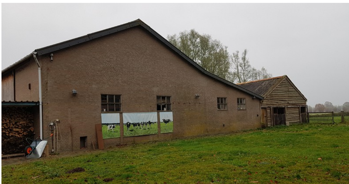
Westelijke gevel van de te slopen loods en aanbouw. Foto: B. Verhoeven | Ecoresult B.V.
