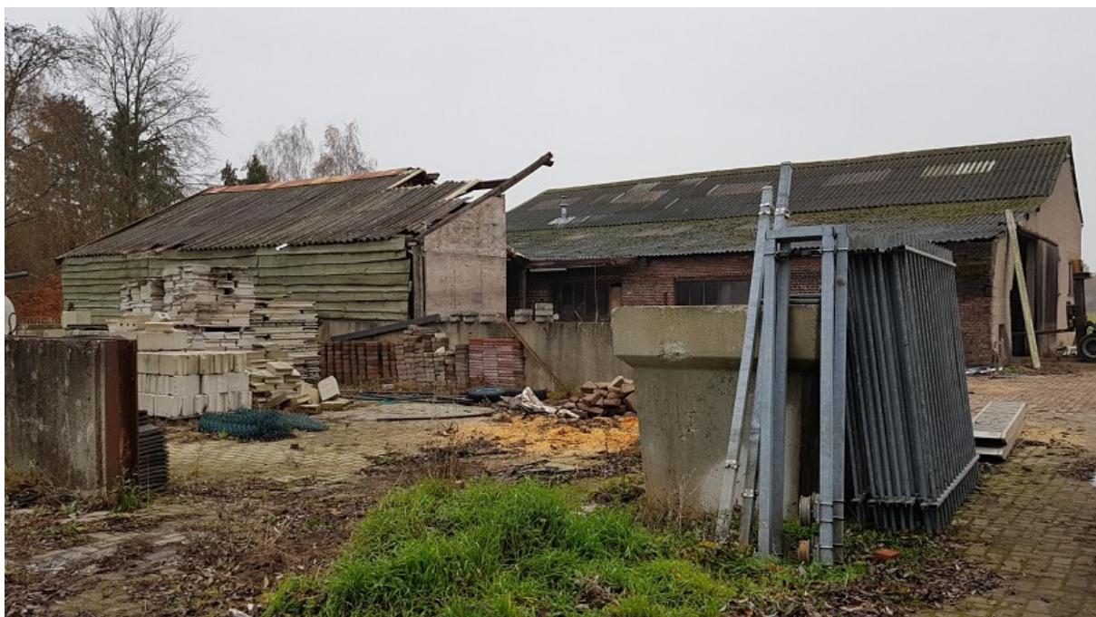
Zuidelijke gevel van de te slopen loods en aanbouw. Foto: B. Verhoeven | Ecoresult B.V.
