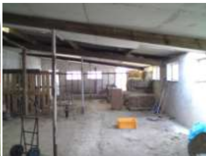
Binnenzijde te slopen voormalige stal in schuur
