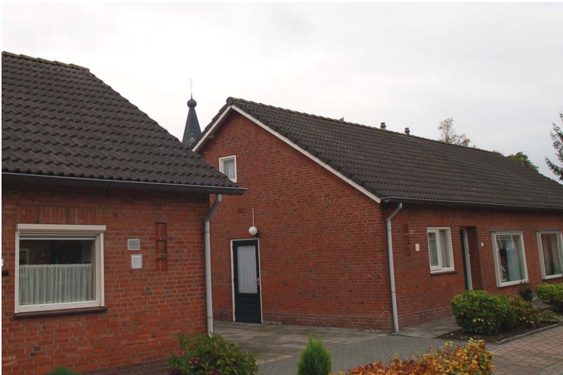
Figuur 3.3. Te slopen bebouwing
