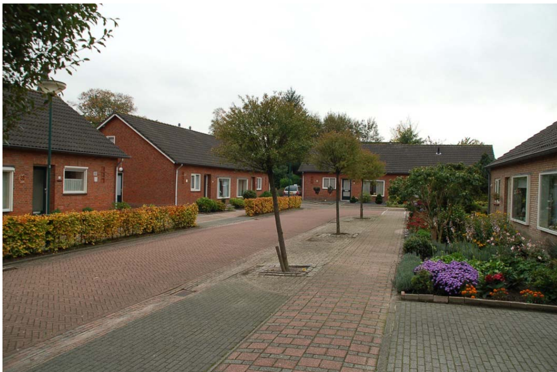
Kleinschalige 2/1 kap woningen van één bouwlaag met een zadeldak
