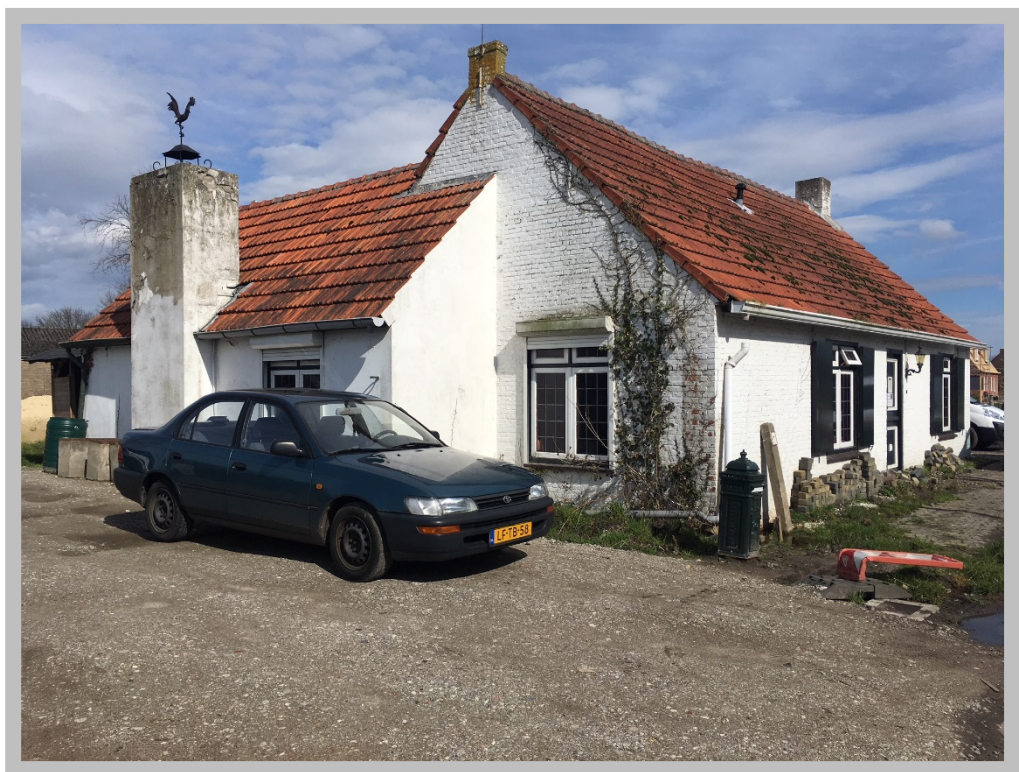
Afbeelding 2 Te slopen woning
