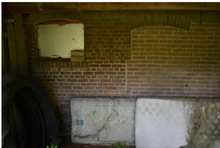
Dichtgezette vensteropeningen en inboetwerk in achtergevel.
