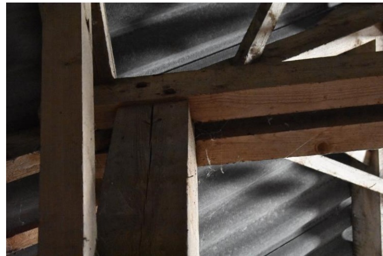
Dekbalkgebint met telmerk V.
