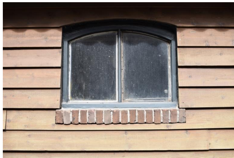
Getoogd betonnen tweeruits stalvenster in de rechterzijgevel.
