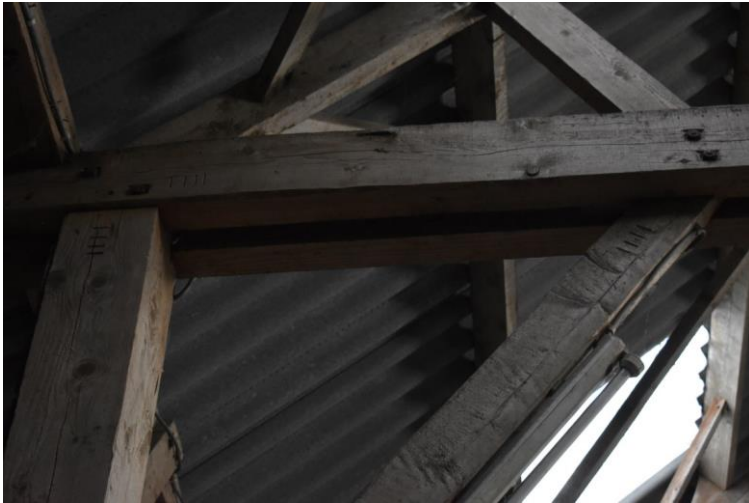
Dekbalkgebint met telmerk IIII.
