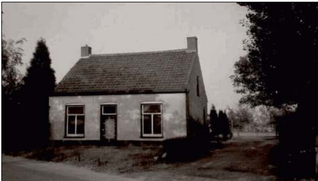
De voormalige bebouwing aan de St. Jacobsstraat 1a.
