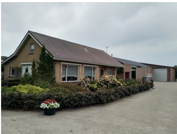
Afbeelding woonhuis met op de achtergrond de te slopen schuur. De woning ligt buiten het plangebied maar wel in de directe omgeving ervan.
