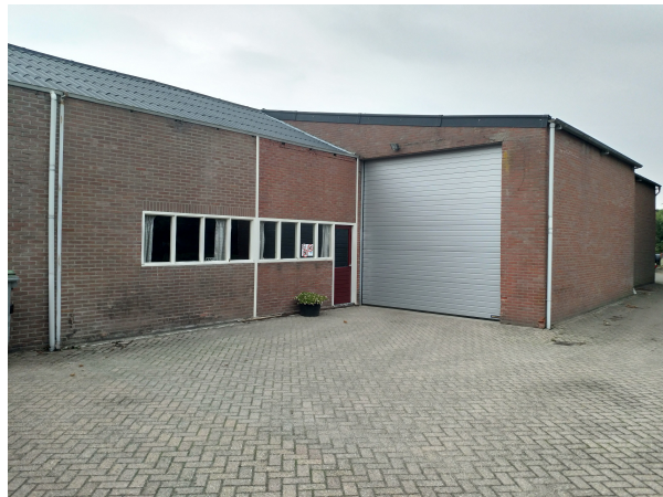
Afbeelding 3. Oostzijde te slopen schuur
