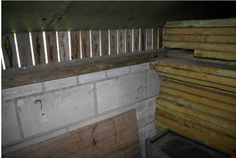
Figuur 4.4.1. De spouwen in de lange gevels van de voormalige pluimveestallen zijn afgedekt met muurplaten.
