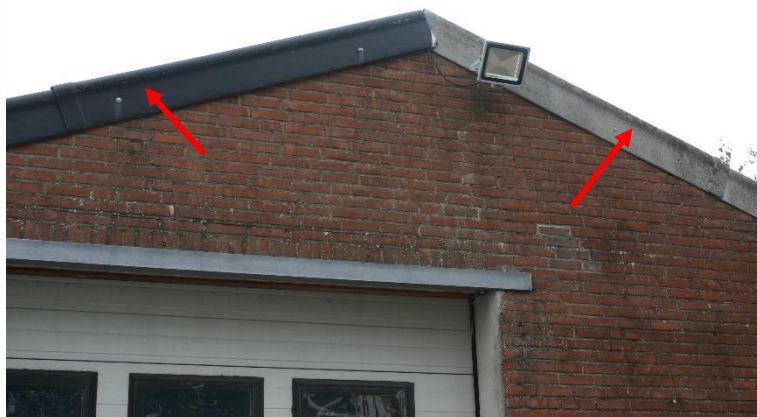
Figuur 4.4.5. Via de kieren (aangeduid met rode pijlen) in de kopkanten van elke voormalige pluimveestal kunnen vleermuizen naar binnen.
