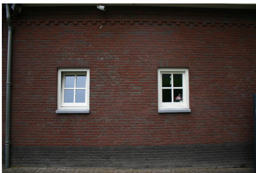
Figuur 6.3. De gevels van de woning aan de Oude Tilburgsebaan 6 bevatten tijdens het veldbezoek (nog) geen open stootvoegen.
