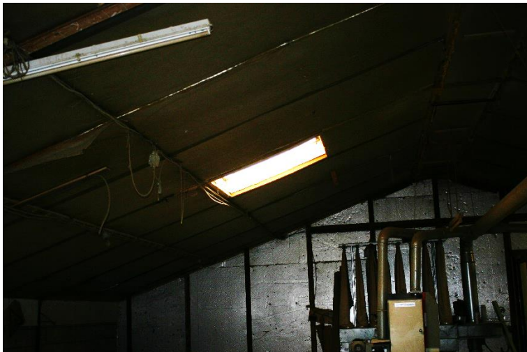
Figuur 4.4.2. Onder een deel van de cementshoudende golfplaten zijn isolerende platen aangebracht.
