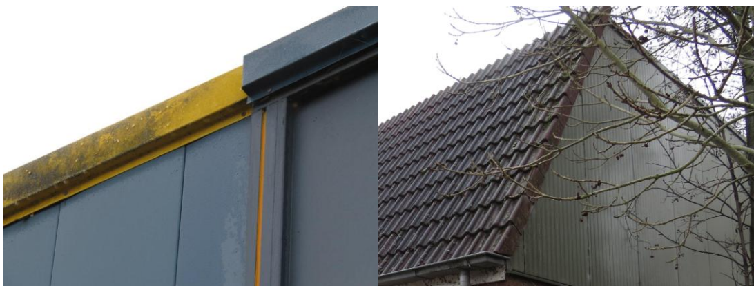
Foto's 3 en 4. Details van de gevels en dak van de gebouwen in het plangebied (foto's A&W 2016)
