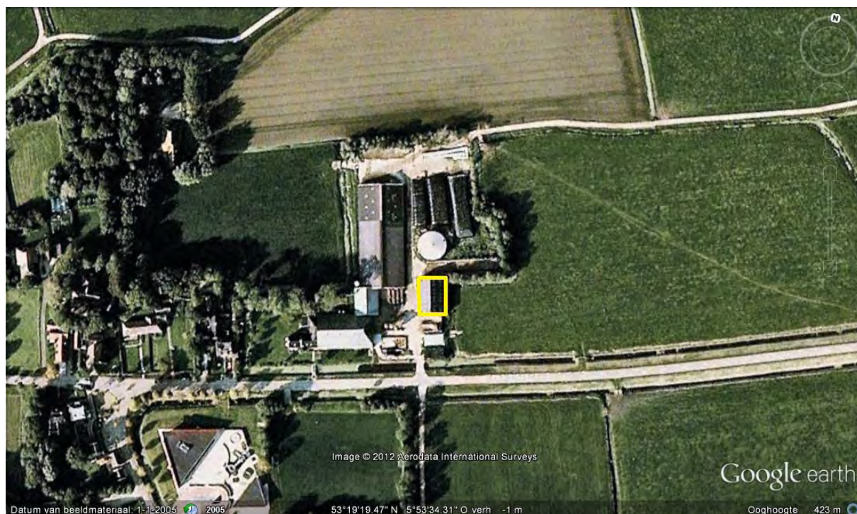
Afbeelding 1. Het bedrijf van de Firma Deelstra. Geel omkaderd de af te breken schuur. De op deze Google Earth opname uit 2005 aanwezige bosschages aan de oostzijde van het bedrijf bleken op het moment van het terreinbezoek al te zijn gekapt.
