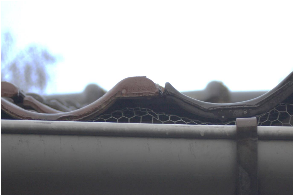
De ruimte tussen de goot en de gevel van de bedrijfsruimte is overal afgewerkt met kippengaas
