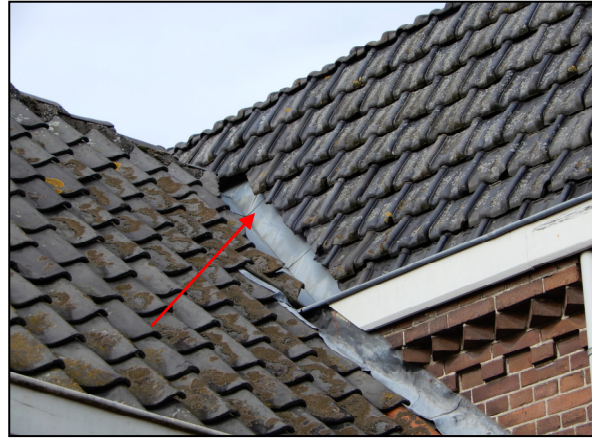
Foto 2: geschikte ruimtes onder dakpannen, voor o.a. de huismus.
