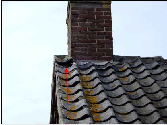
Foto 1: ruimte onder de dakpannen, geschikt voor de gierzwaluw en huismus.
