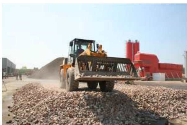
figuur 4 Aanbrengen proefvak
