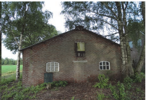
Figuur 8: Vooraanzicht van een van de te slopen schuren
