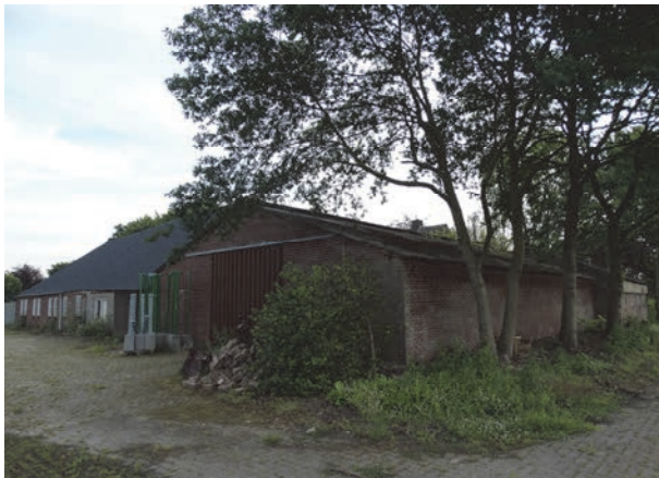
Figuur 9: Achteraanzicht van de te slopen schuren
