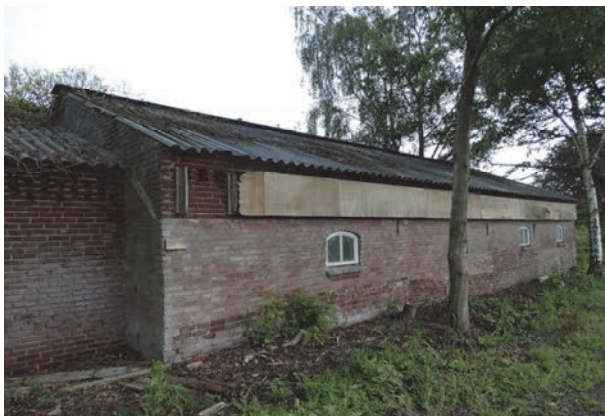
Figuur 7: Zijaanzicht van een van de te slopen schuren
