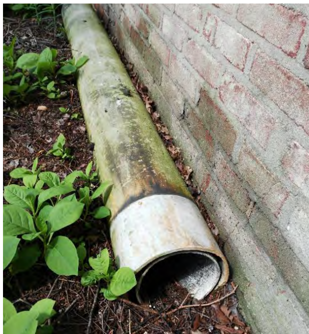
Afbeelding 7: asbestverdachte buis
