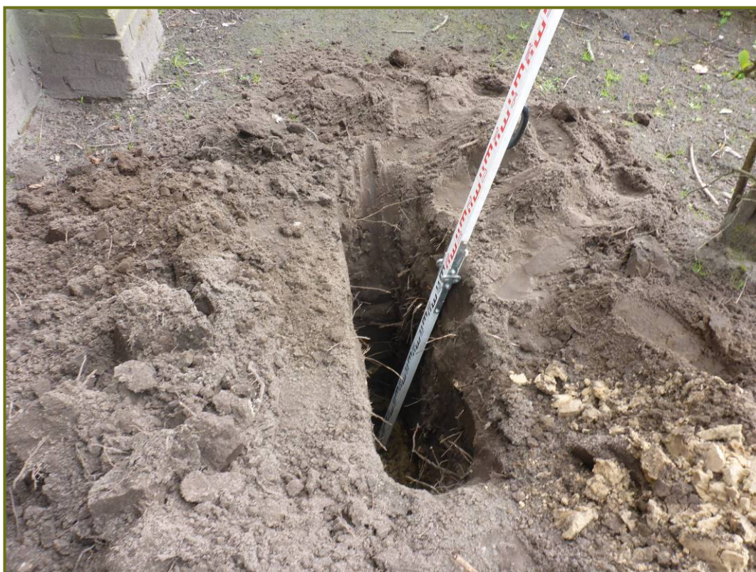
Afbeelding 9. Profielkuil 2 bij boom 4
