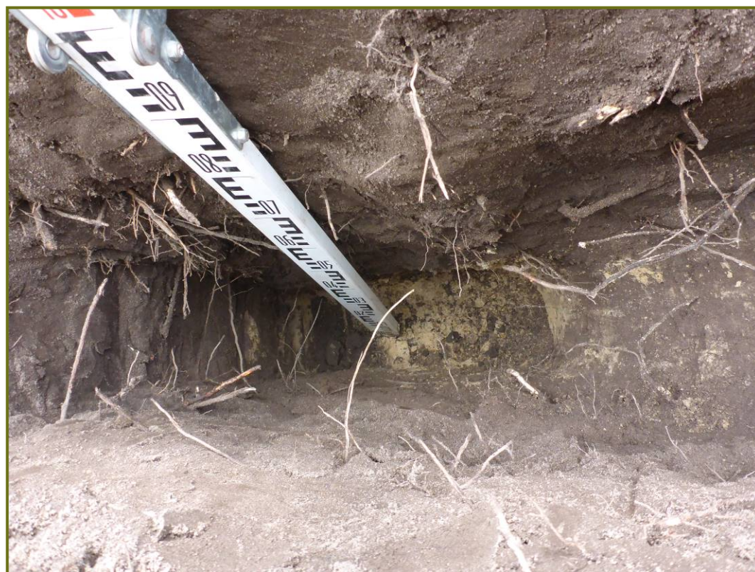
Afbeelding 10. Profielkuil 2 bij boom 4
