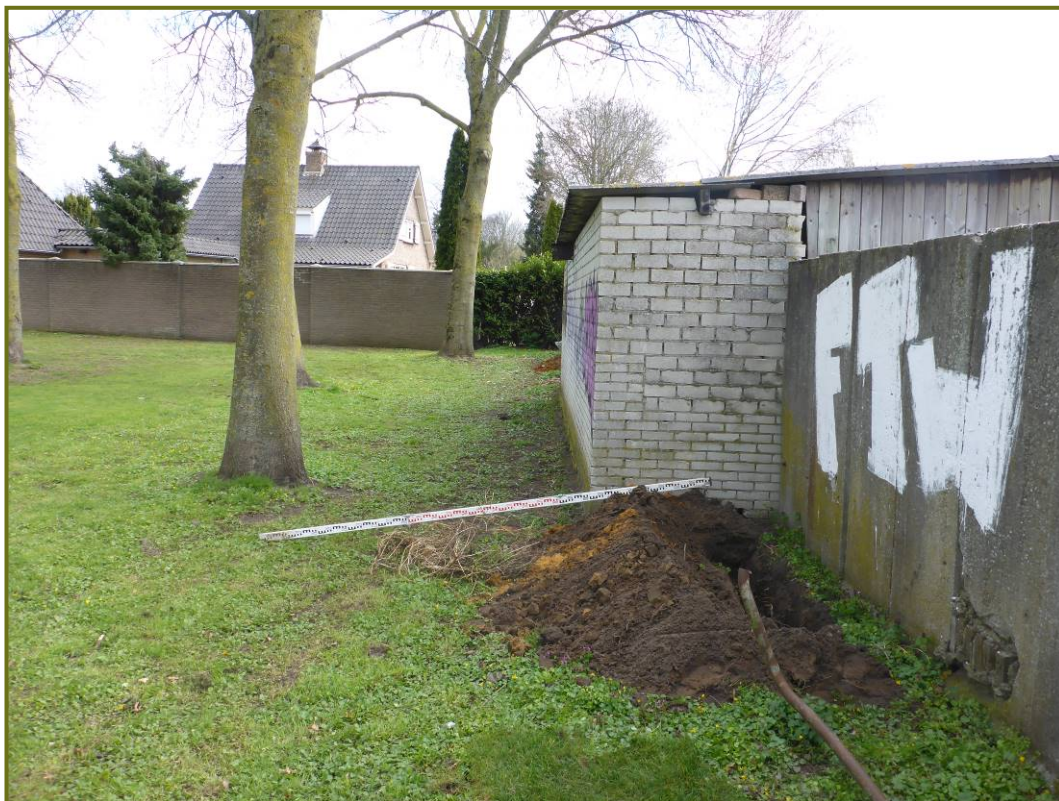
Afbeelding 11. Profielkuil 3 bij boom 7
