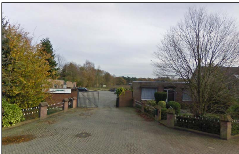
Aan de Kampstraat 1a is een kantoor aanwezig. (locatie C)
