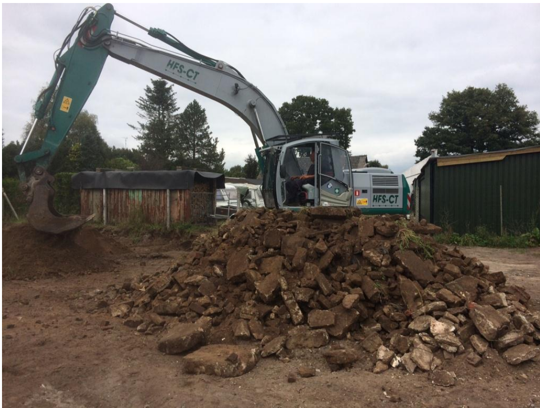
Figuur 1: Ontgraven puinputten en zichtbare bebouwing aanliggende percelen.
