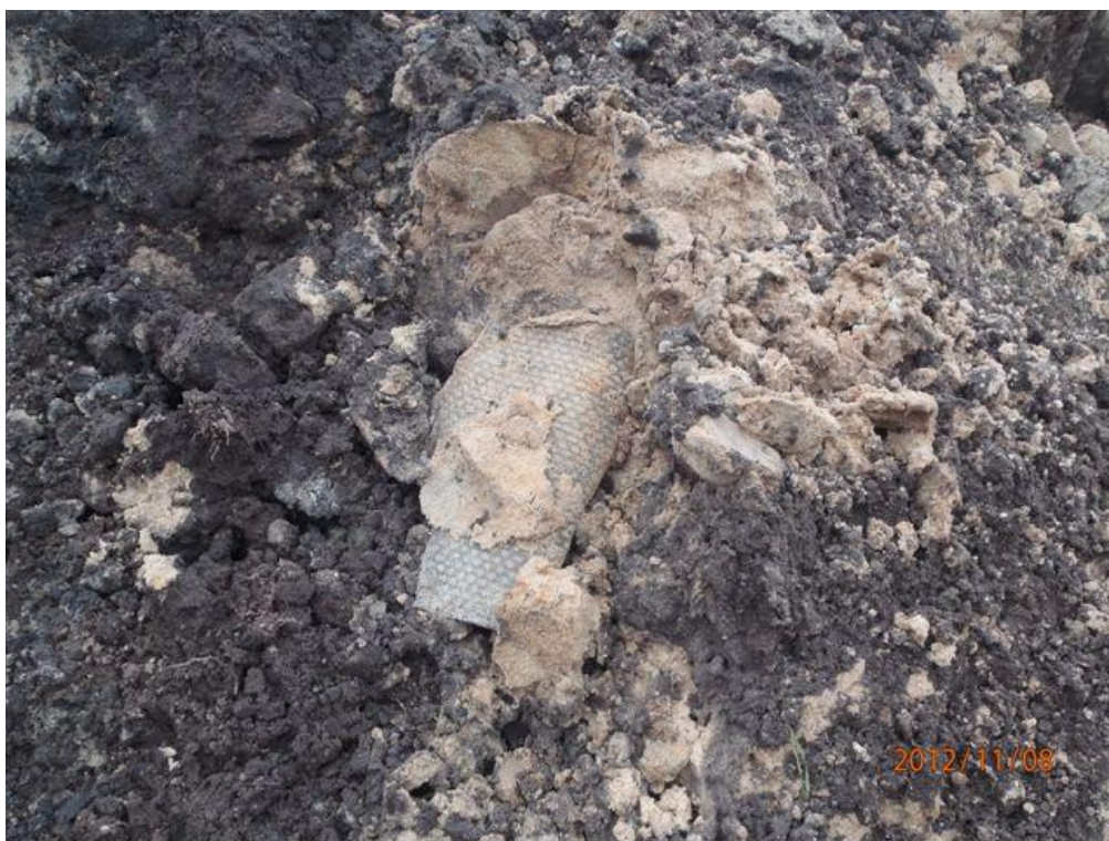
Foto 3 & 4: asbesthoudend materiaal sleuf 10
