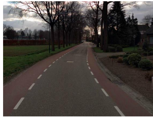
Figuur 15, afwezigheid van trottoirs op Hommelsedijk vanaf Rodenburgseweg richting zuiden
