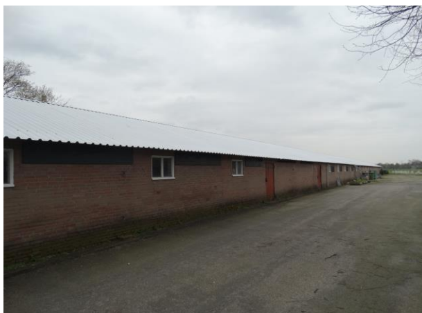
Figuur 9: Aanzicht van de tweede te slopen varkensstal
