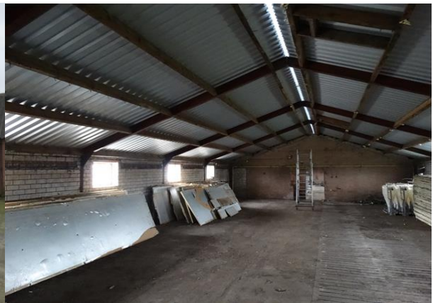
Figuur 4: Binnenzijde van de te slopen varkensstallen
