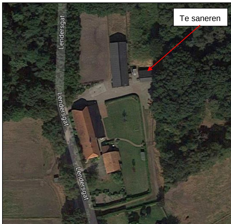
Figuur 7: Te saneren bebouwing
