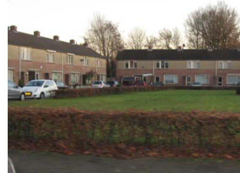
Te slopen woningen aan de Hildebrandstraat
