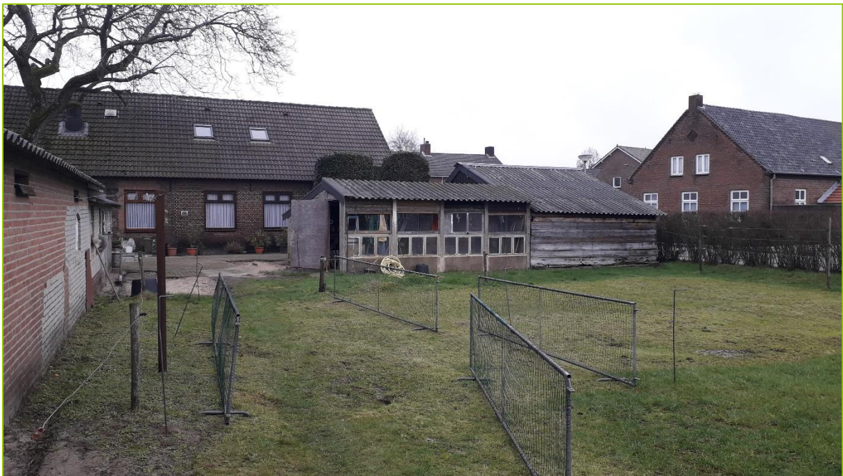
Het bewoonde gedeelte, inclusief enkele bijgebouwen, aan de noordzijde van het perceel blijft behouden
