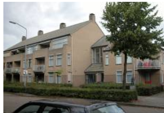
Woningbouw op de hoek Hoogstraat/Pastoor Scheepensstraat
