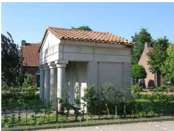
Afbeelding 5.6. Aanwezig gebouw binnen het plangebied Gymnasium.
