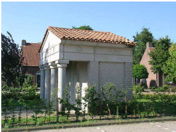
Afbeelding 5.6. Aanwezig gebouw binnen het plangebied Gymnasium.
