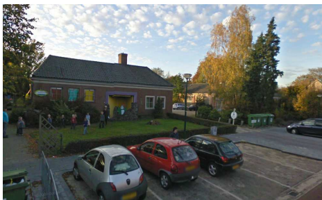
Bestaande bebouwing voormalige school vanaf de Abdijstraat
