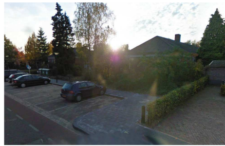
Bestaande bebouwing voormalige school vanaf de Abdijstraat
