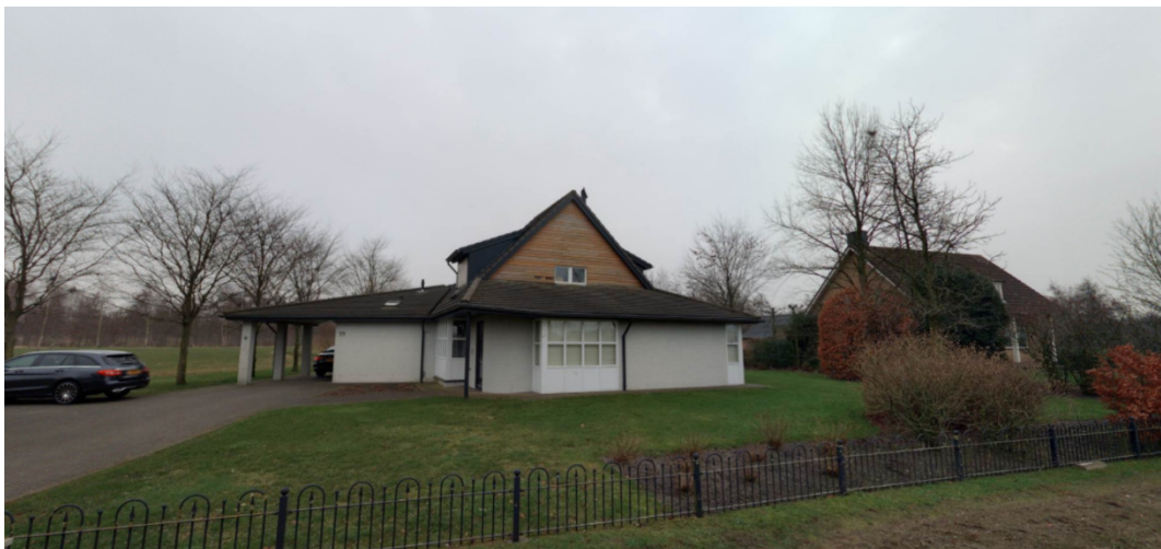
Links de bestaande bebouwing in het plangebied. Rechts de woning Achterstraat 35 (bron: Globespotter 2018)
