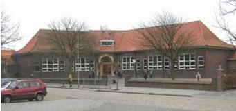
Bestaande deel school 't Rietland
