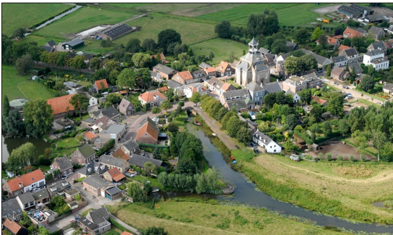
Aanzicht van de kern van het historische bebouwingslint van Hoge Zwaluwe
