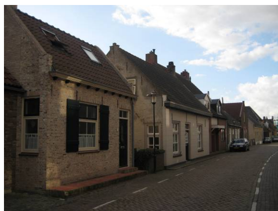
Woningen in één bouwlaag met een kap
